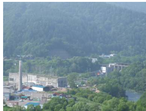
発電所とダム
