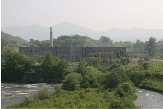
【52 清水沢発電所】
